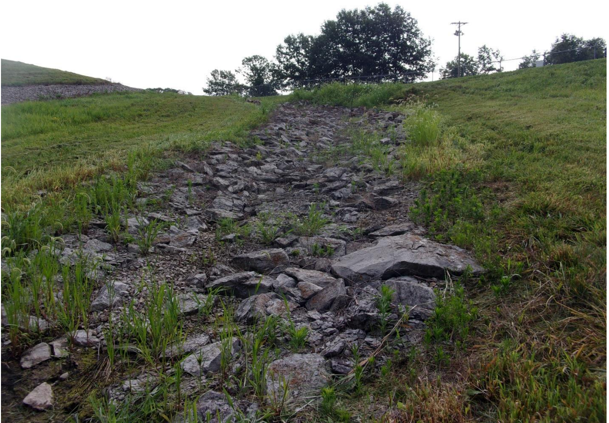
CEA rip rap channel (August 2021).
